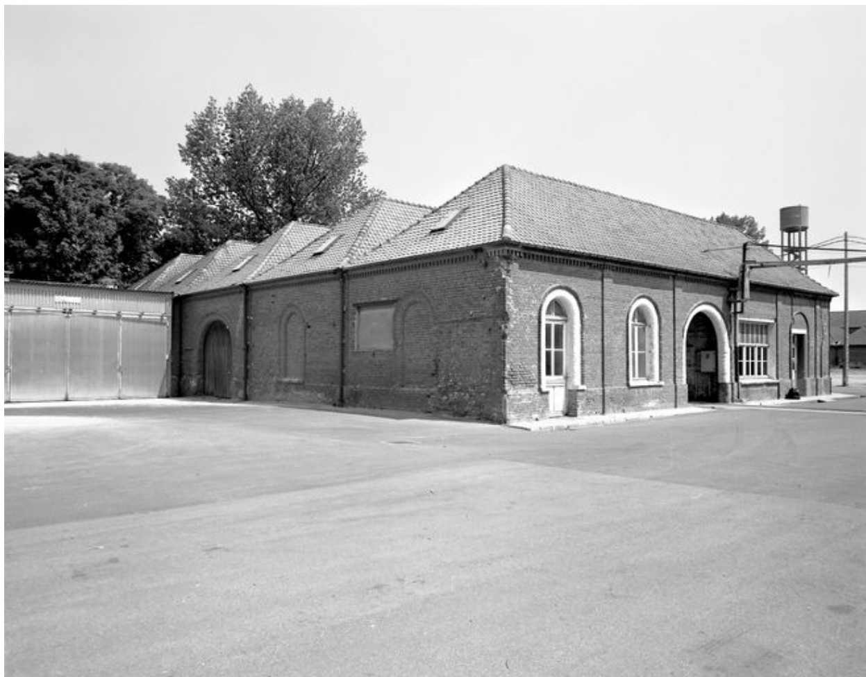
Edifice industriel (dépôt divers), en 1989 : élévation sud-ouest.
