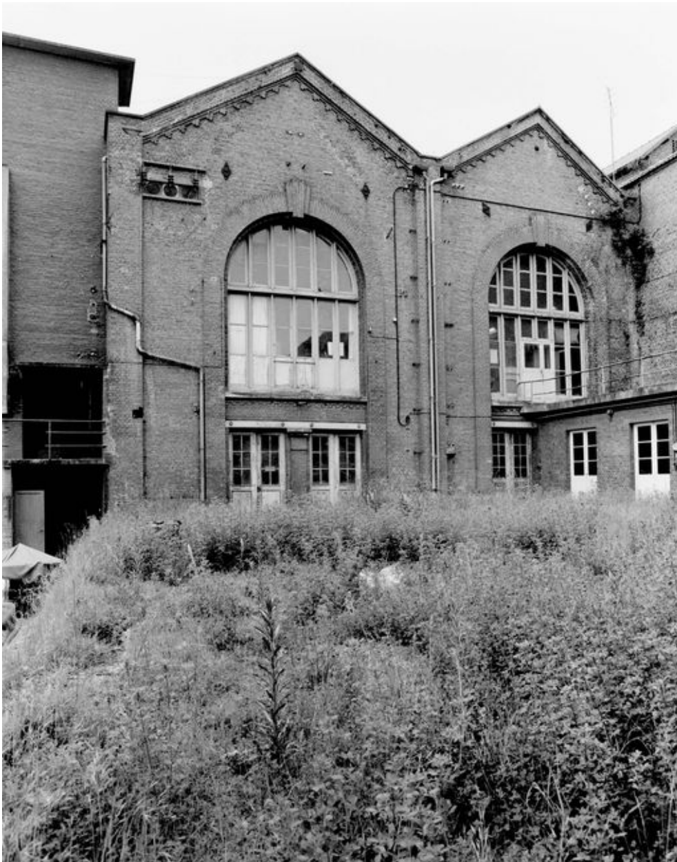
Pignons latéraux de l'ancienne bûcherie. Etat en 1988.
