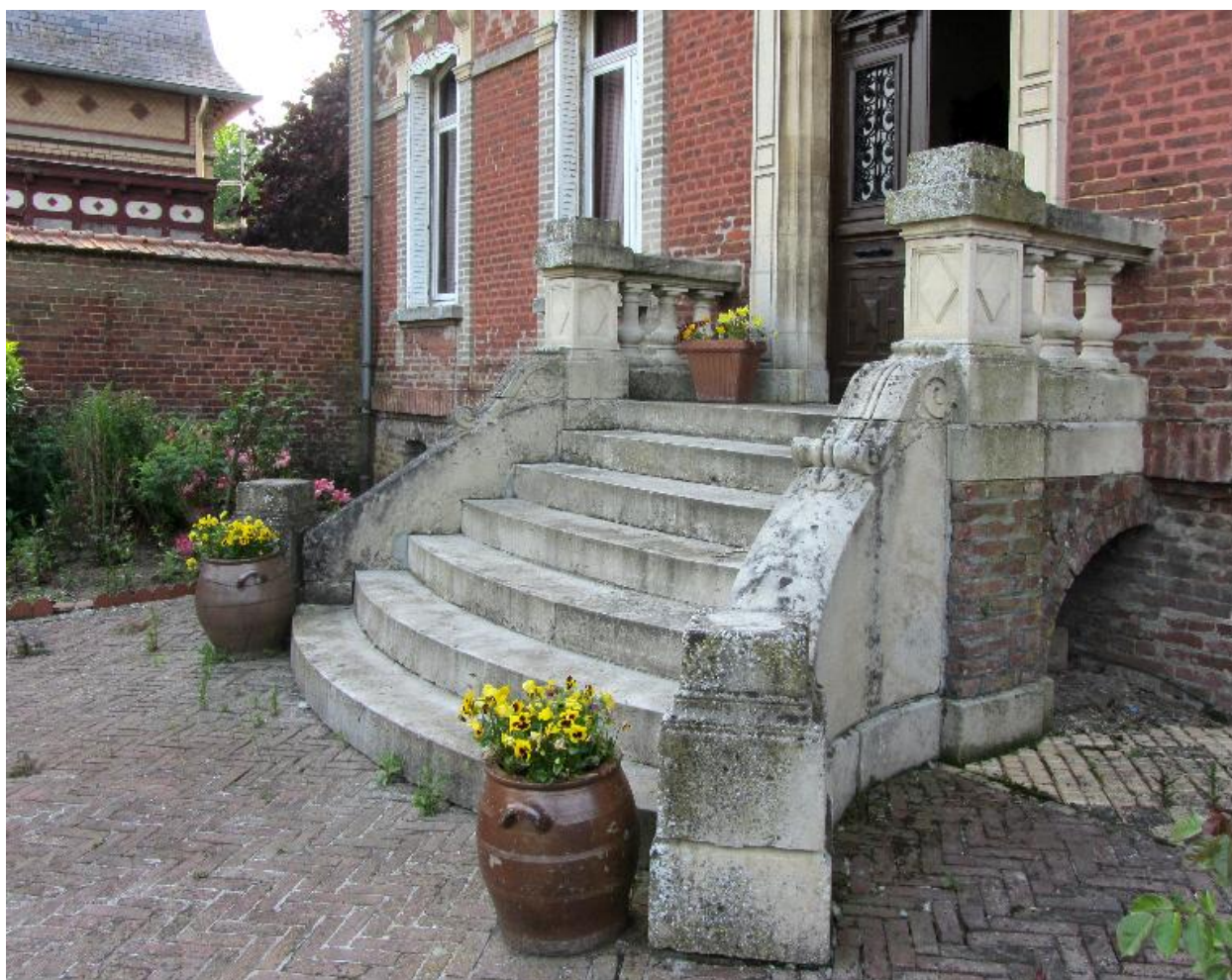
Détail de l'escalier.
