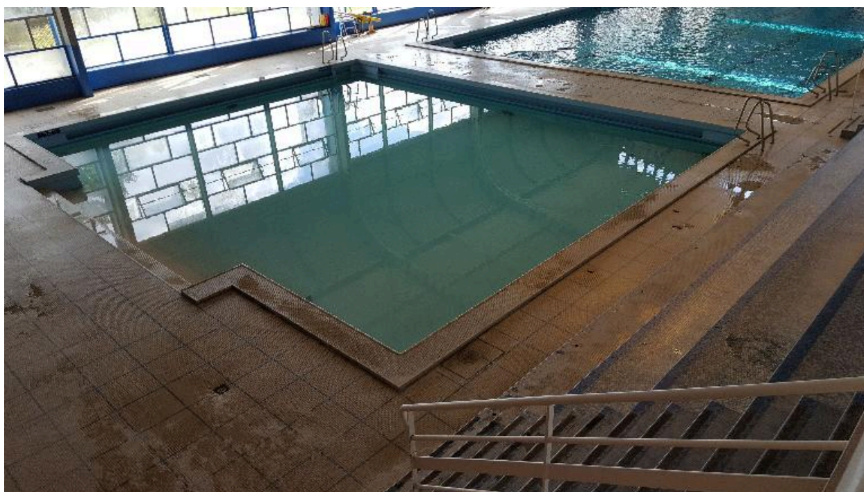
Vue du bassin d'apprentissage (12,5 x 12,5 mètres) , où l'on entre grâce à des escaliers.
