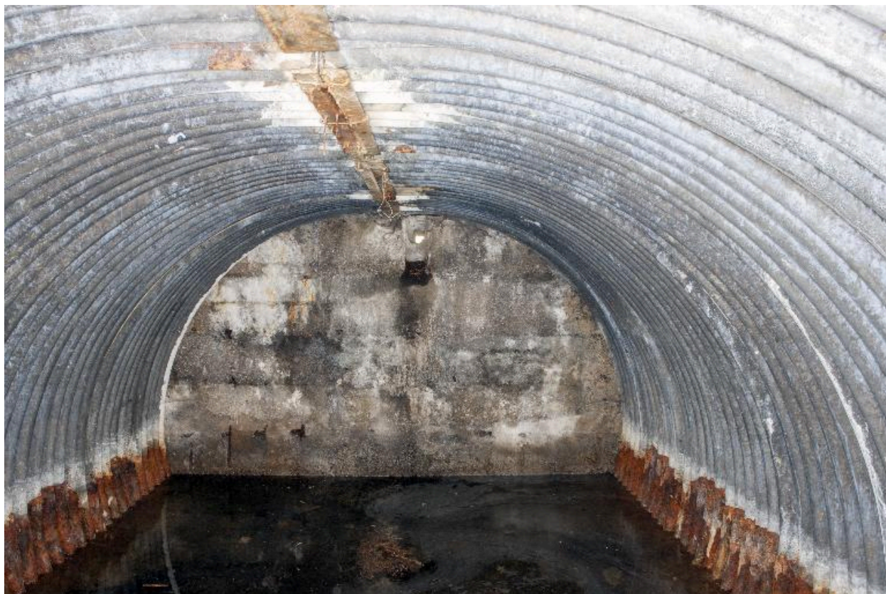
L'abri à personnel, depuis le couloir
