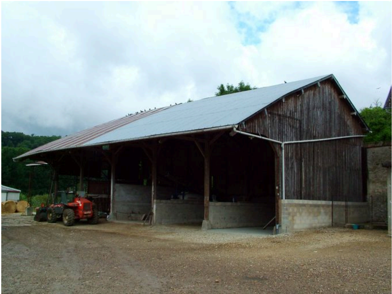
Vue du hangar.
