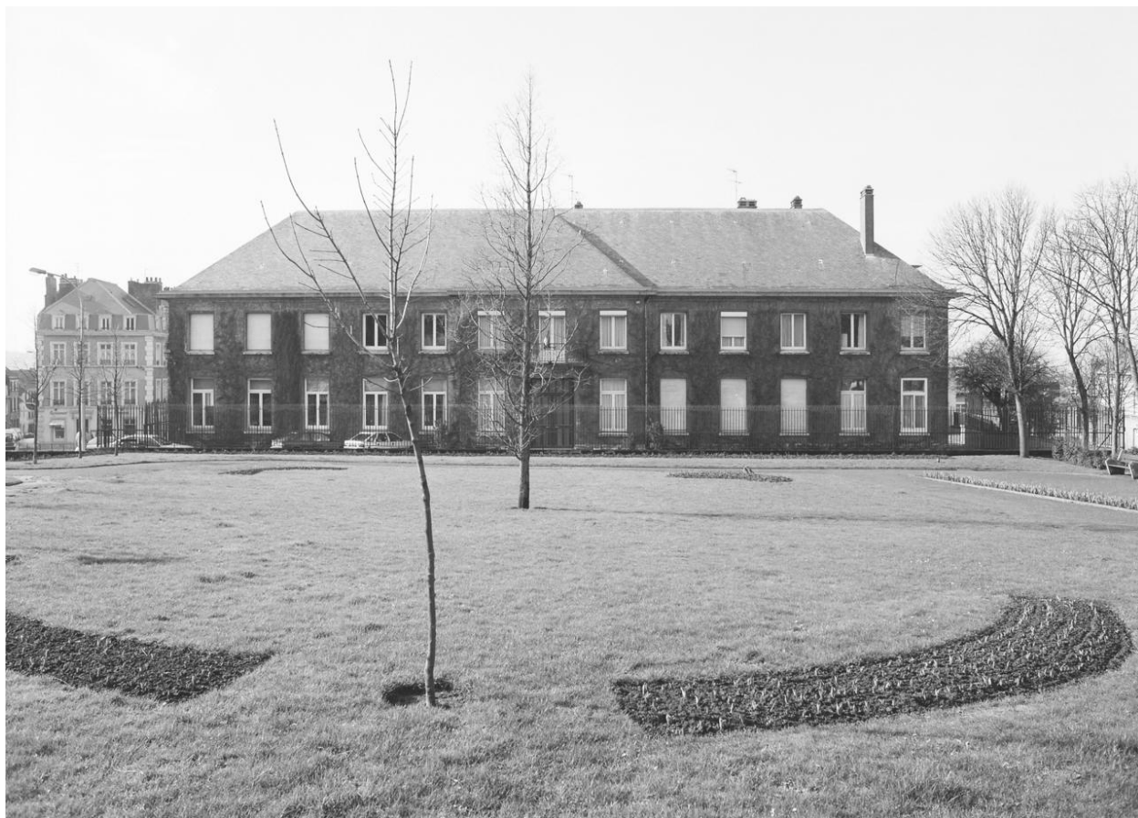
Façade sur square du bâtiment actuel.
