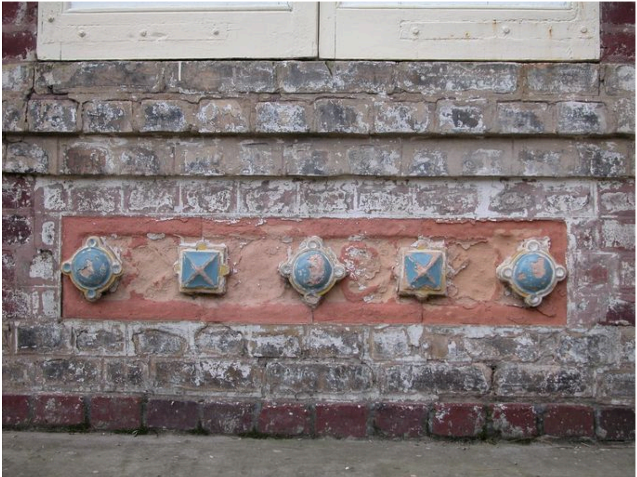
Détail du décor porté en façade.
