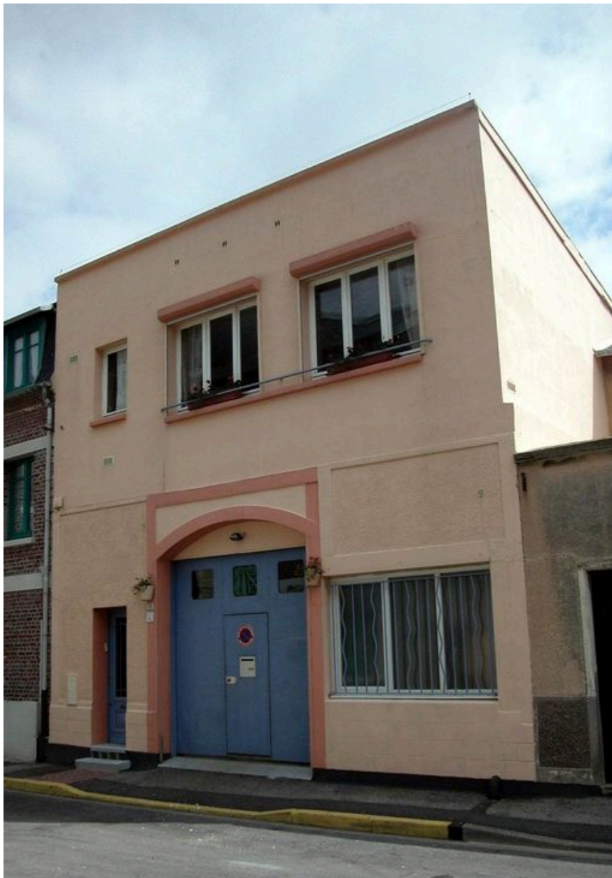
Maison, 13 rue Faidherbe.
