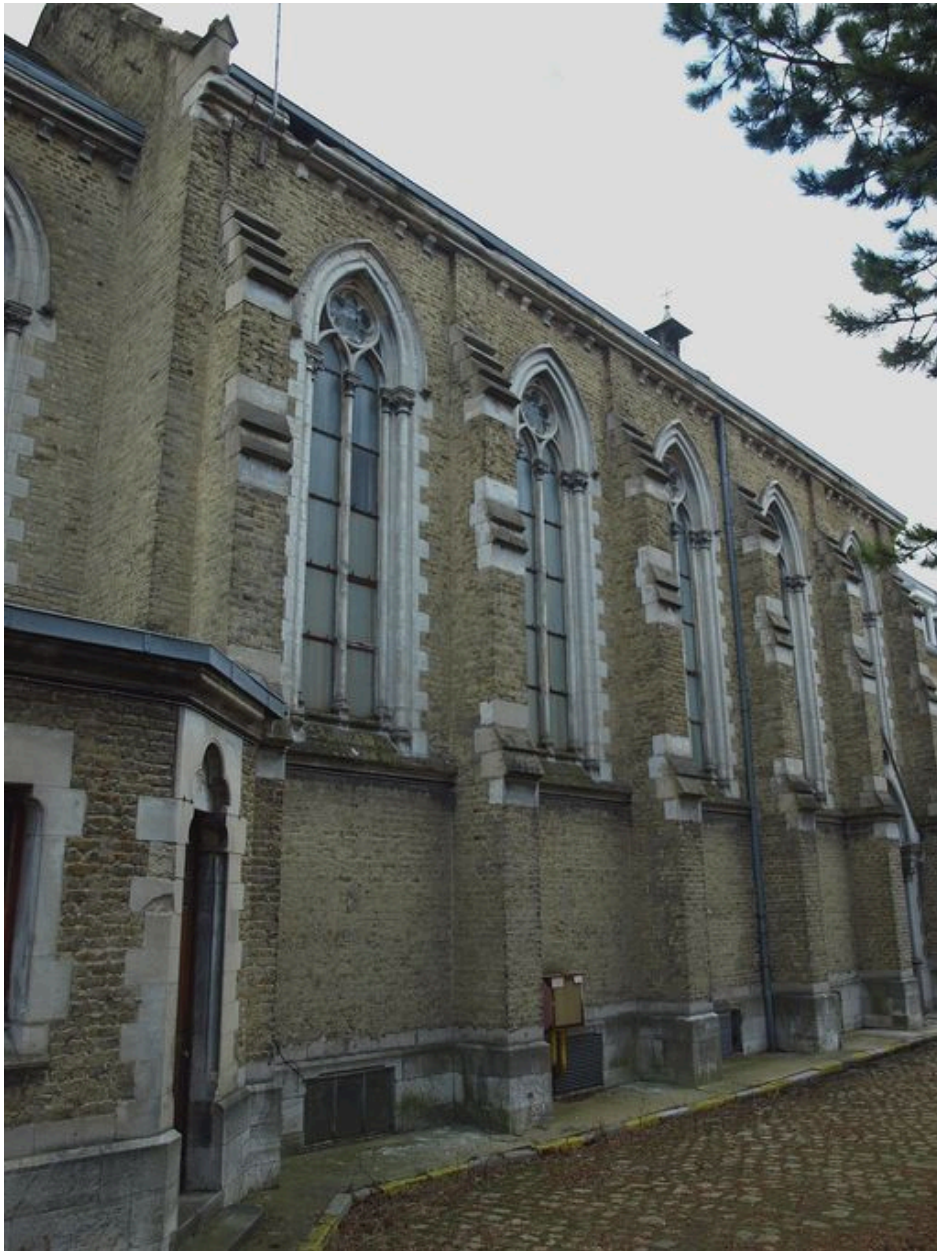
Chapelle : murs latéraux
