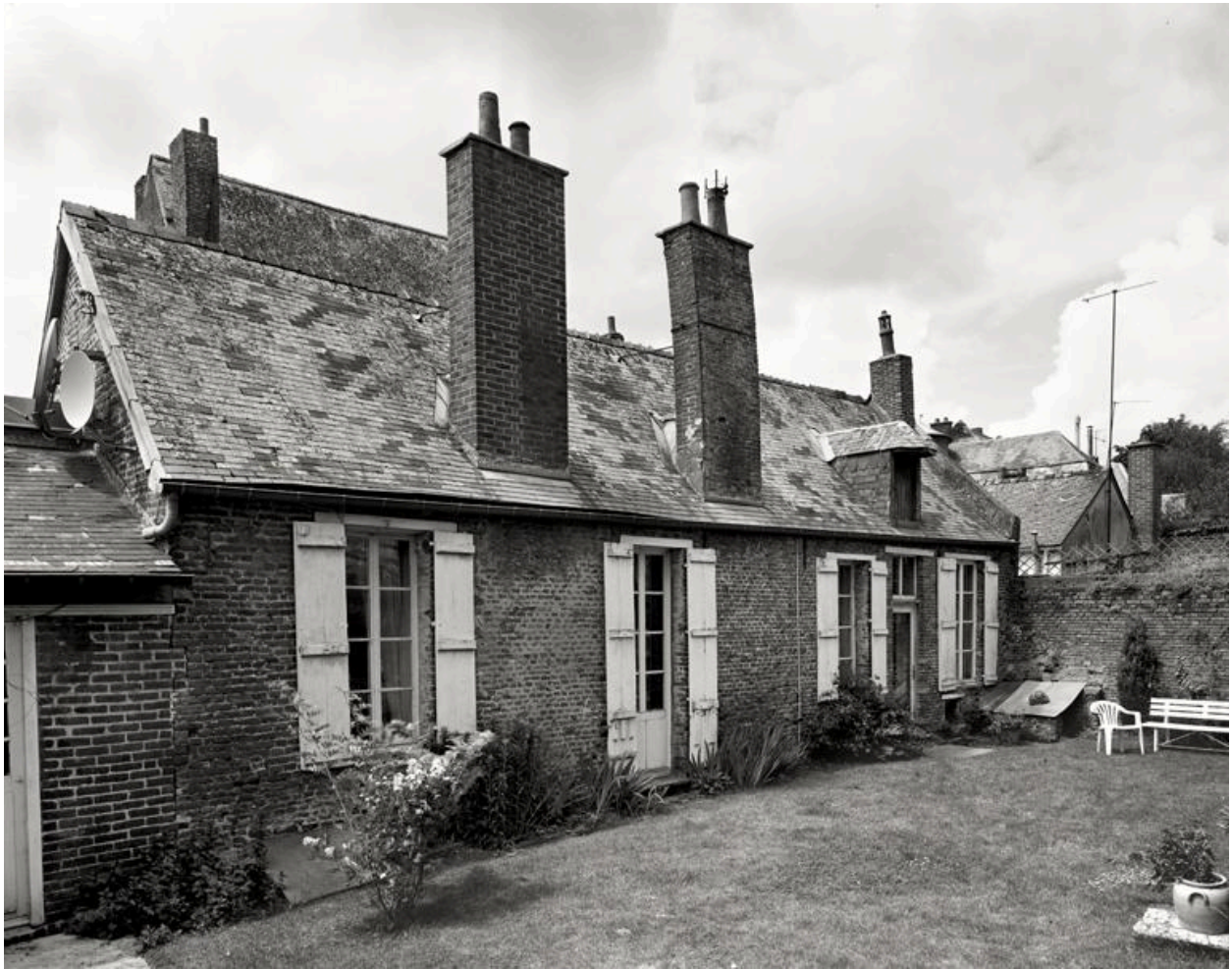
Vue de l'élévation orientale du bâtiment, construite entre cour et jardin.
