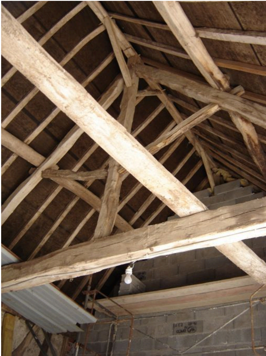
Vue détaillée de la charpente.
