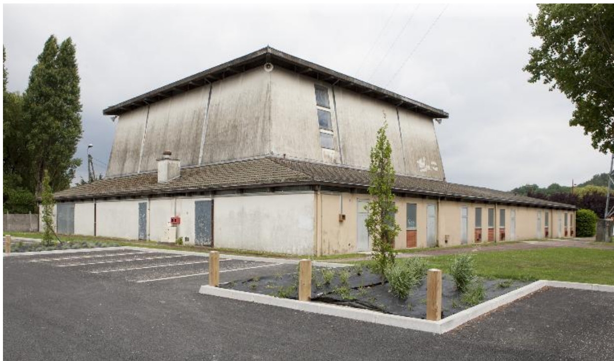
Vue de trois-quart, arrière gauche de l'église.
