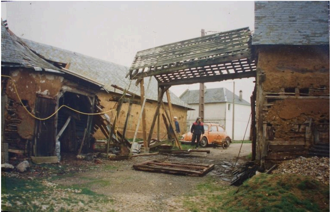
Vue du corps de passage en cours de démantèlement.
