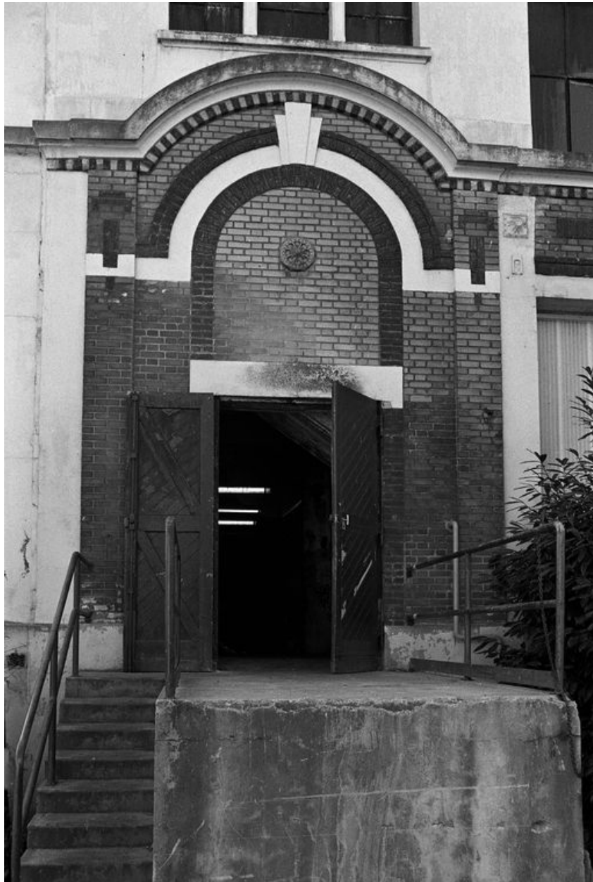
Atelier de fabrication sud. Détail.
