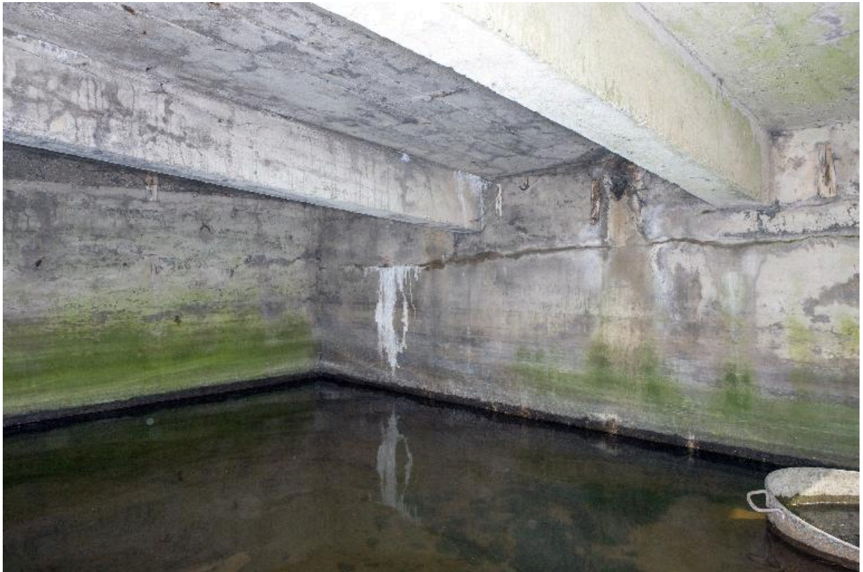
Vue intérieure de la soute à munitions
