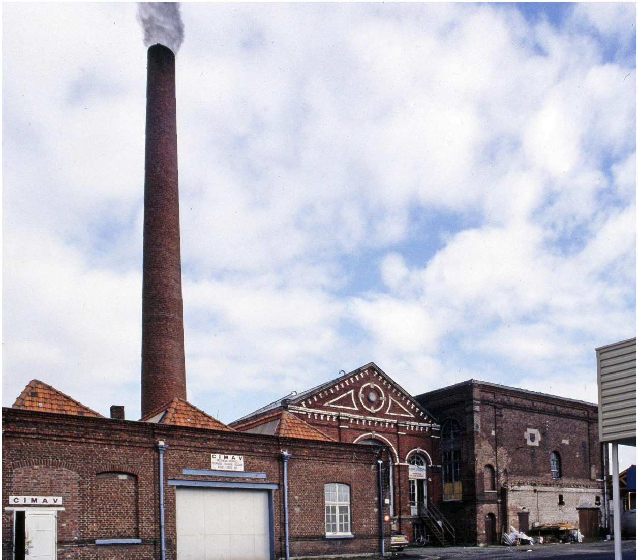
Vue générale vers l'est prise depuis la cour.
