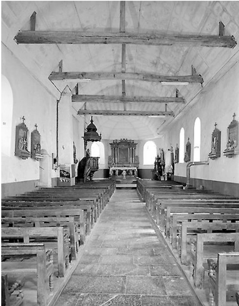
Vue intérieure de la nef vers le chœur.
