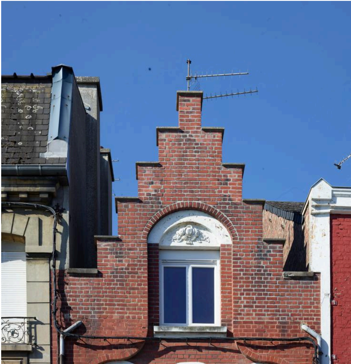
Détail du pignon à redents.
