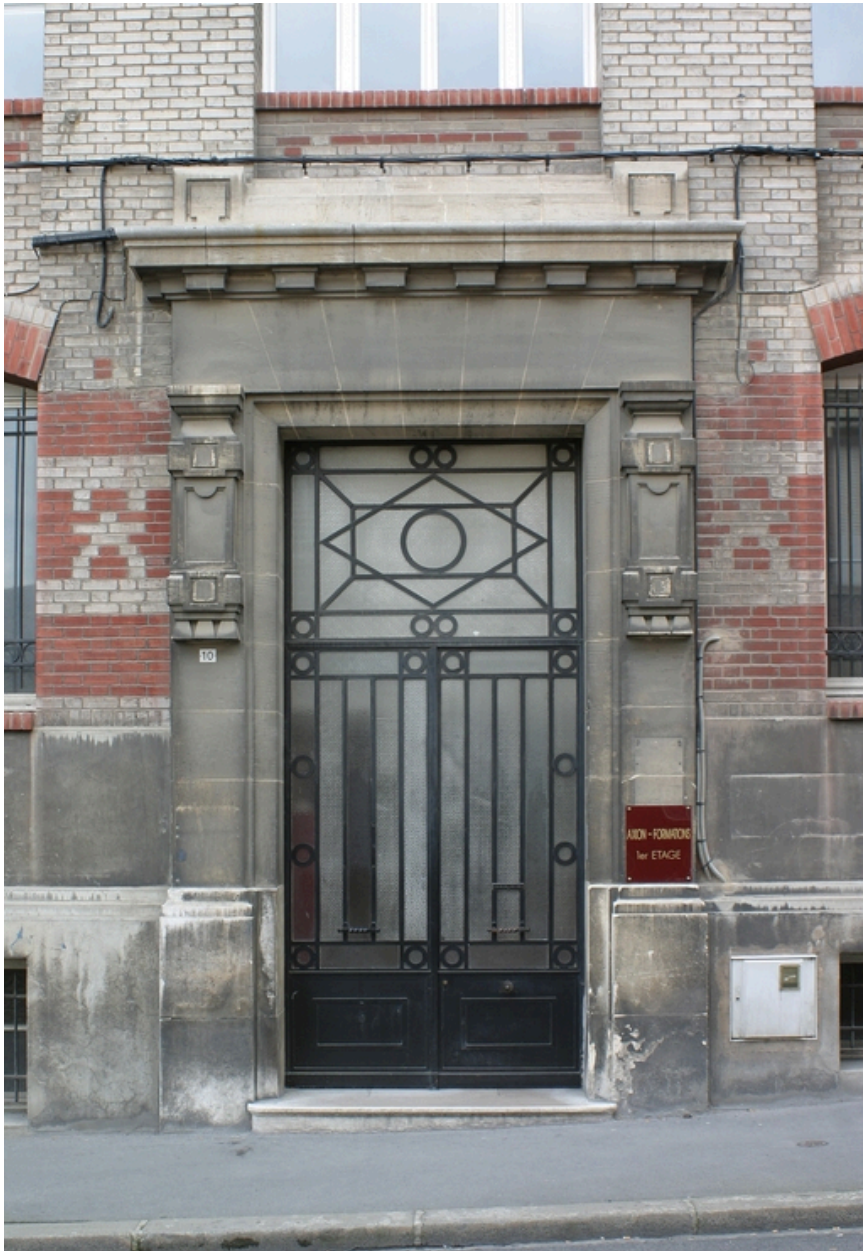
Entrée rue du Général Foy.
