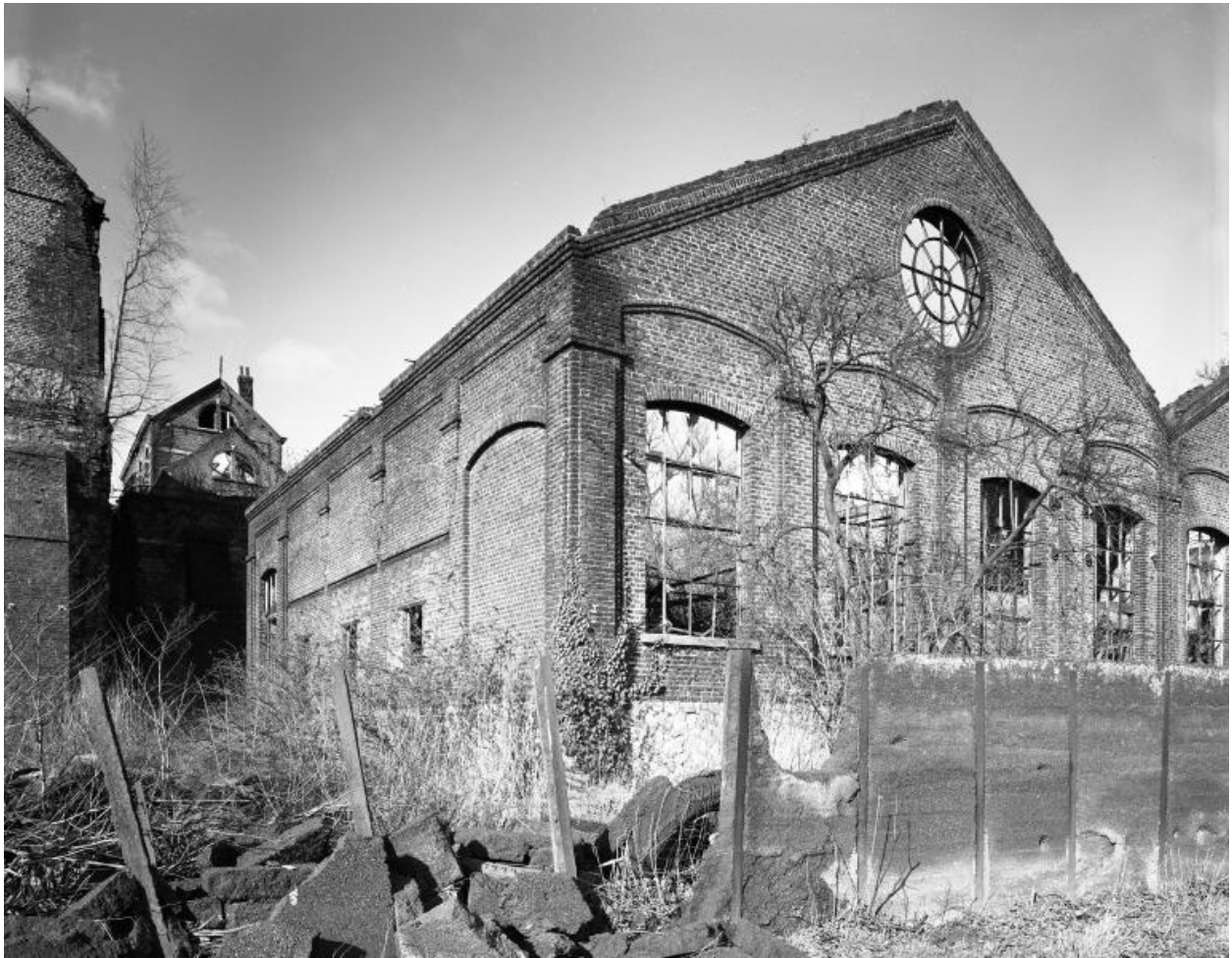
Sous-station électrique. Élévation sur la Sambre. À l'arrière-plan, à gauche, la conciergerie.
