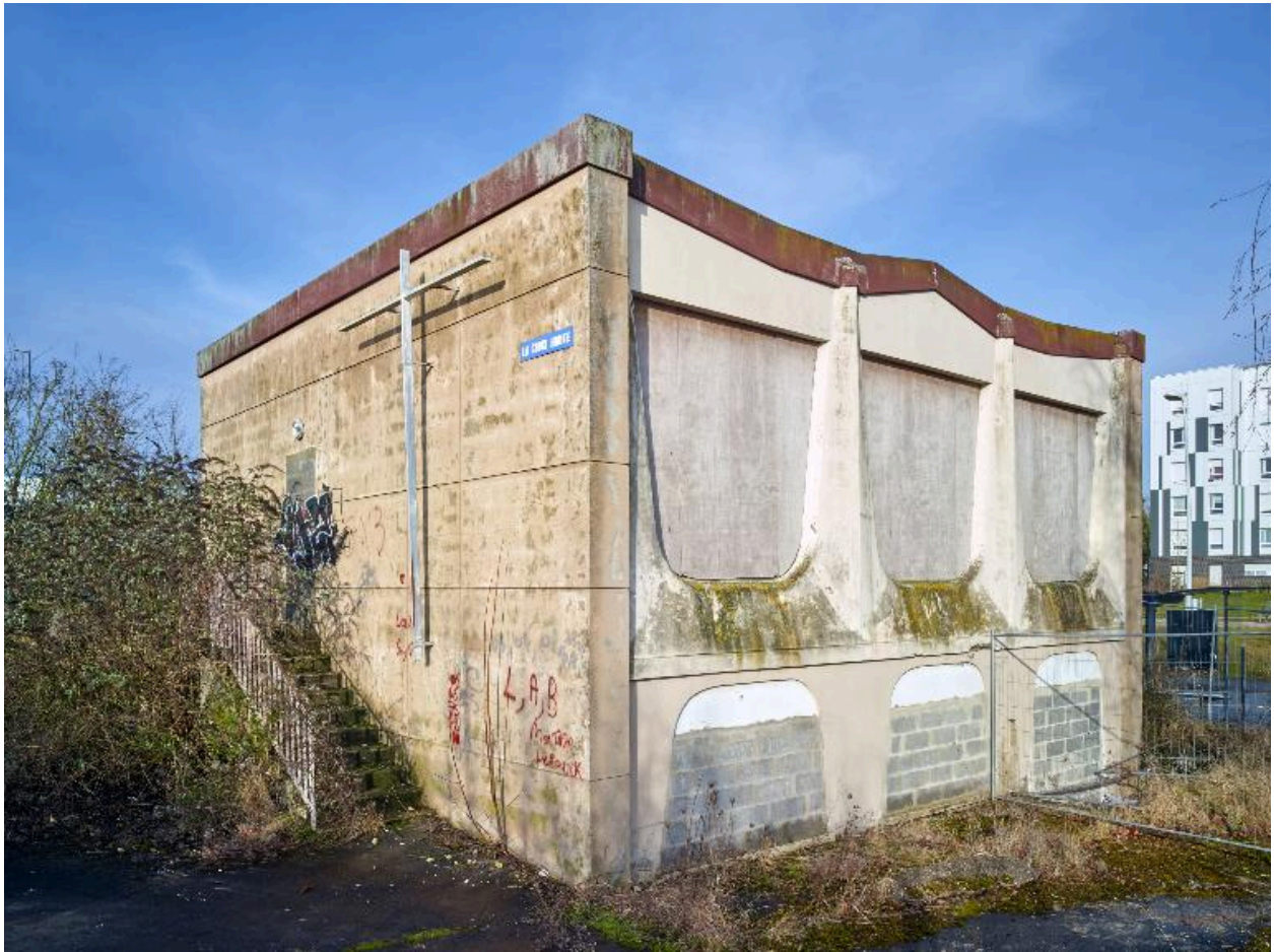
Élévation sud et ouest de l'édifice.
