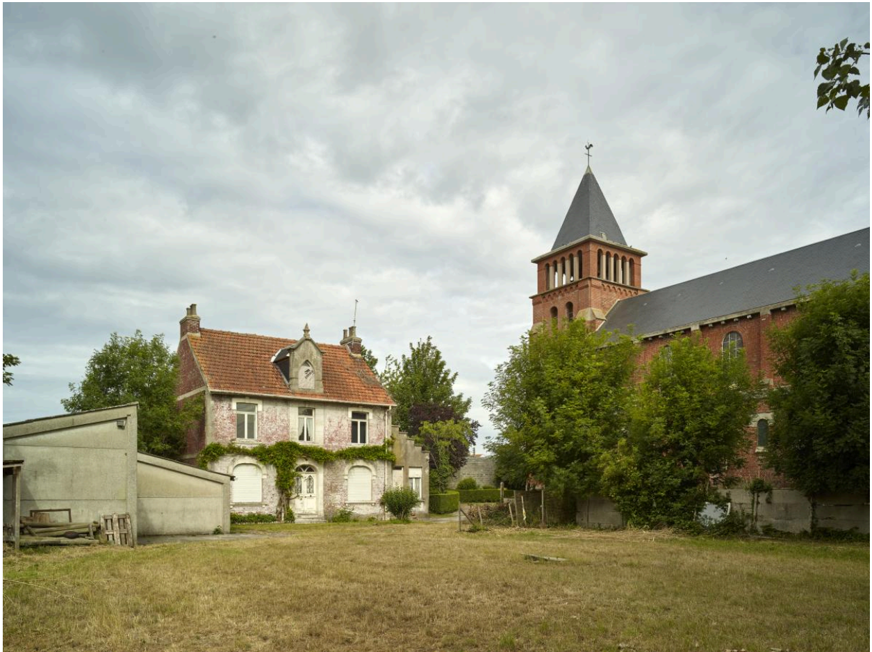
Vue générale de l'église et de son presbytère.
