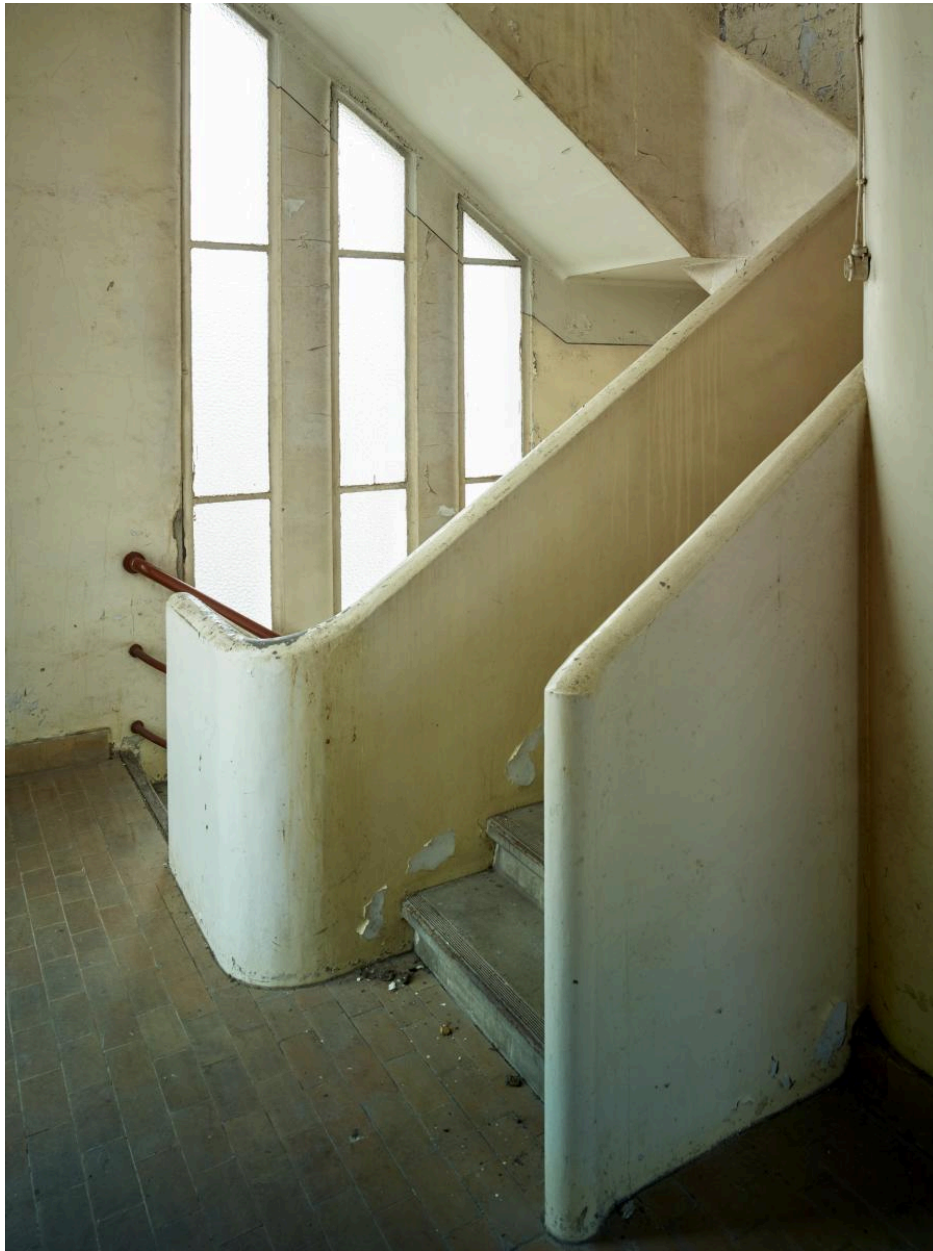
Vue intérieure de la tour d'angle de l'atelier de fabrication (H). Palier.
