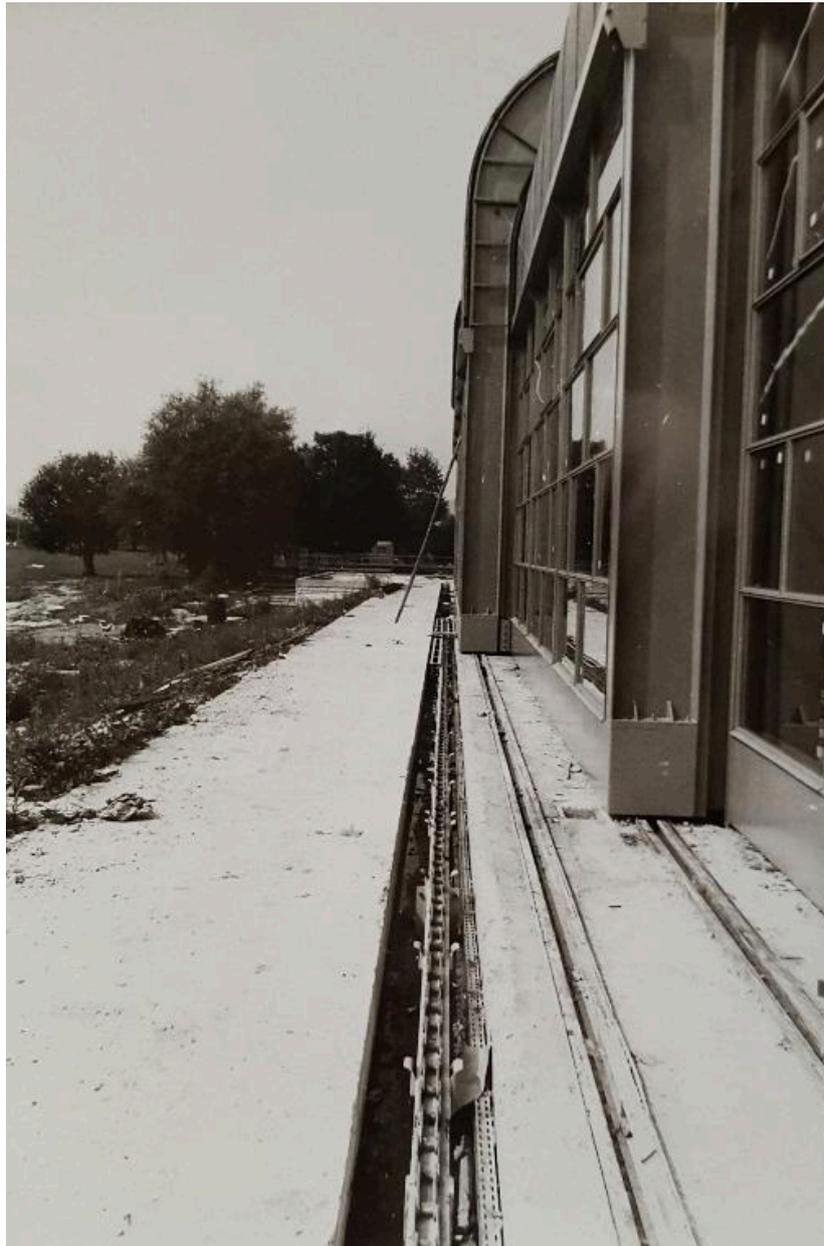
Vue des rails permettant aux éléments mobiles de s'ouvrir. Vue de chantier, juillet 1967.
