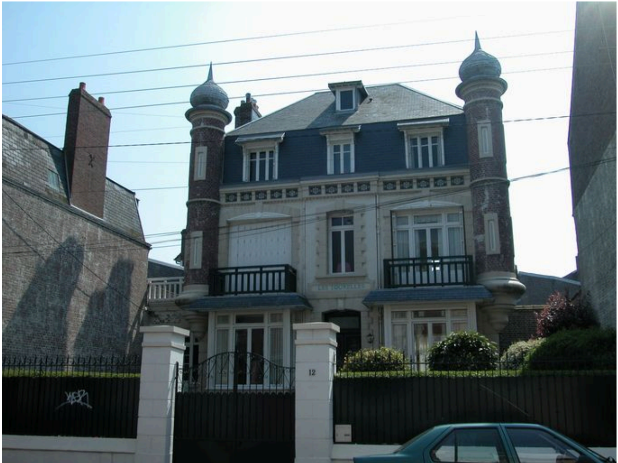
Vue d'ensemble depuis la rue.
