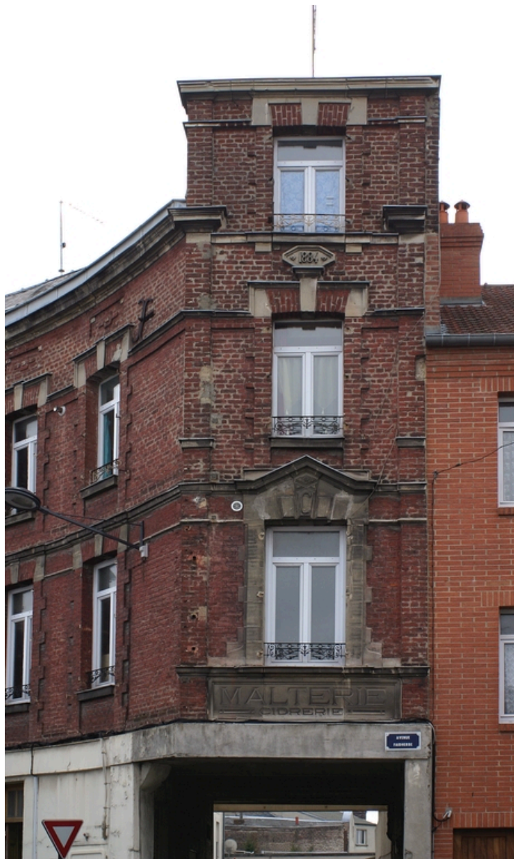
Façade antérieure des logements d'employés.
