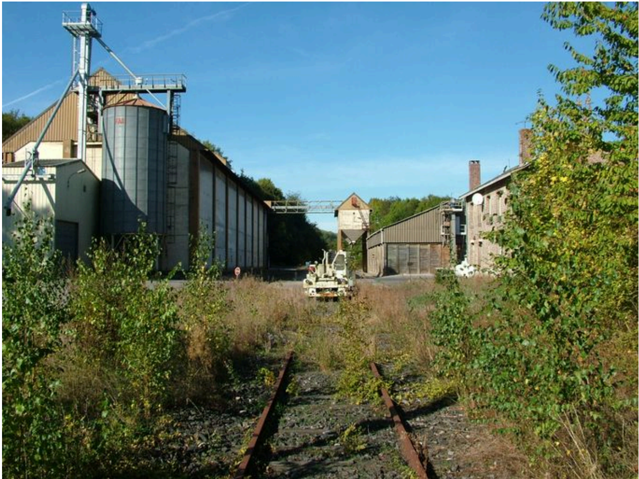
Canaples. Les bâtiments de stockage du Réveil agricole de Picardie de part et d'autre de la voie ferrée.
