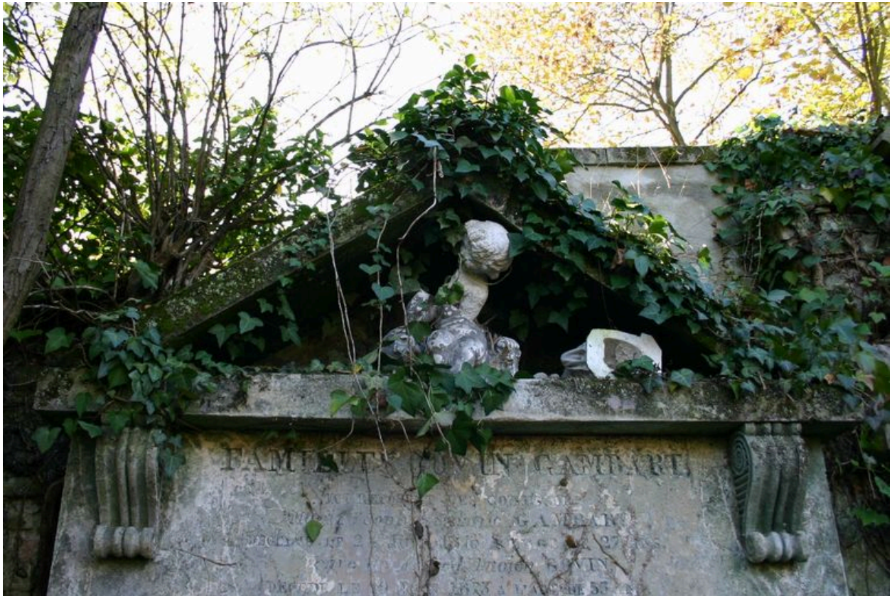
Détail du fronton à usage de niche.
