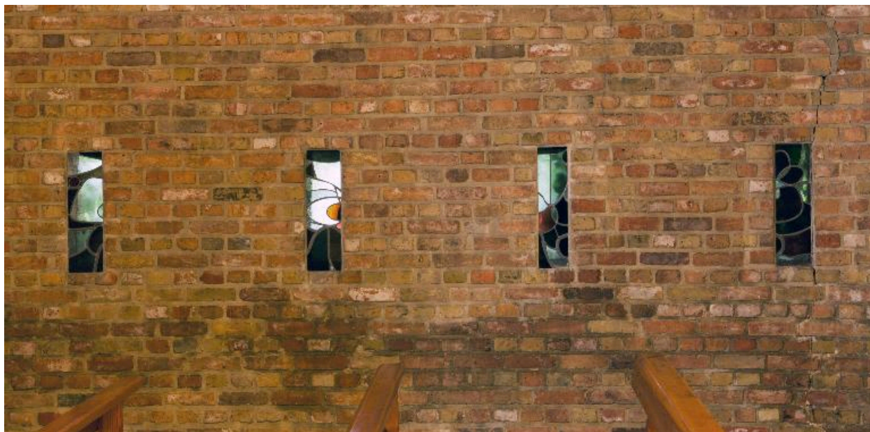
Vue des verrières côté droit.
