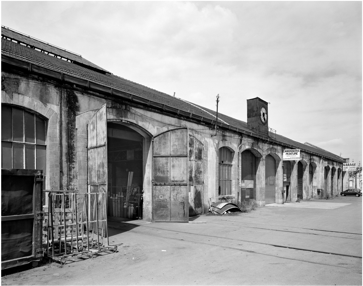
Entrepôts de réparation des locomotives : vue rapprochée.
