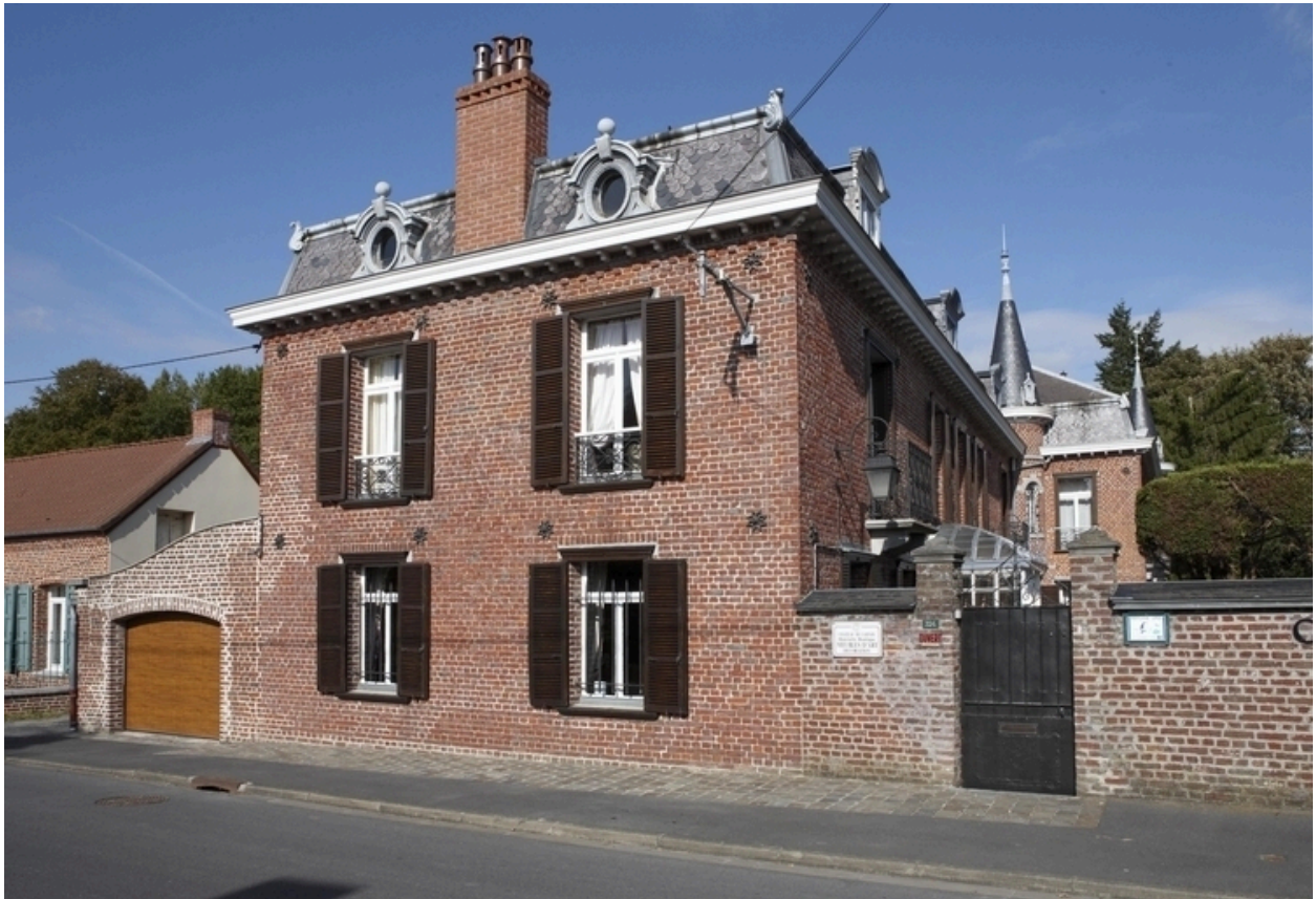
Vue de l'élévation sur rue.
