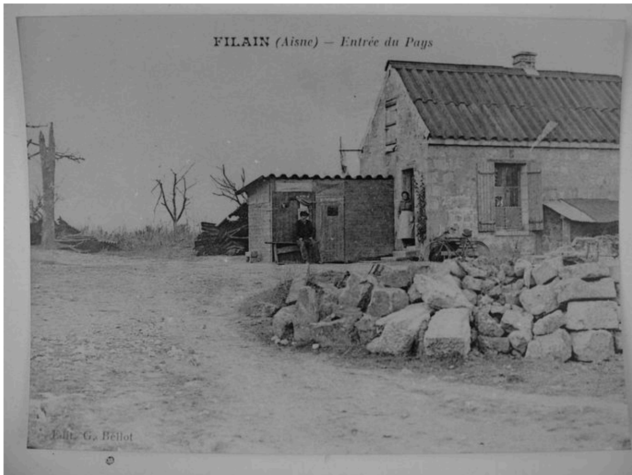
Vue de l'entrée du village pendant la reconstruction (coll. part).
