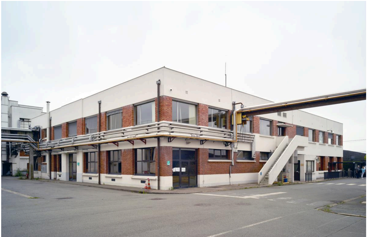
Vue de trois-quarts vers le nord-ouest du bâtiment abritant réfectoire (C) et bureaux (D).
