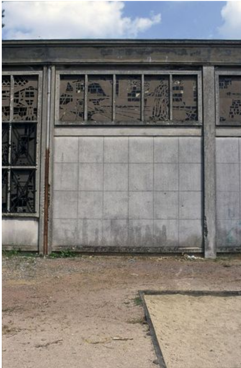
Vue partielle de l'élévation ouest.
