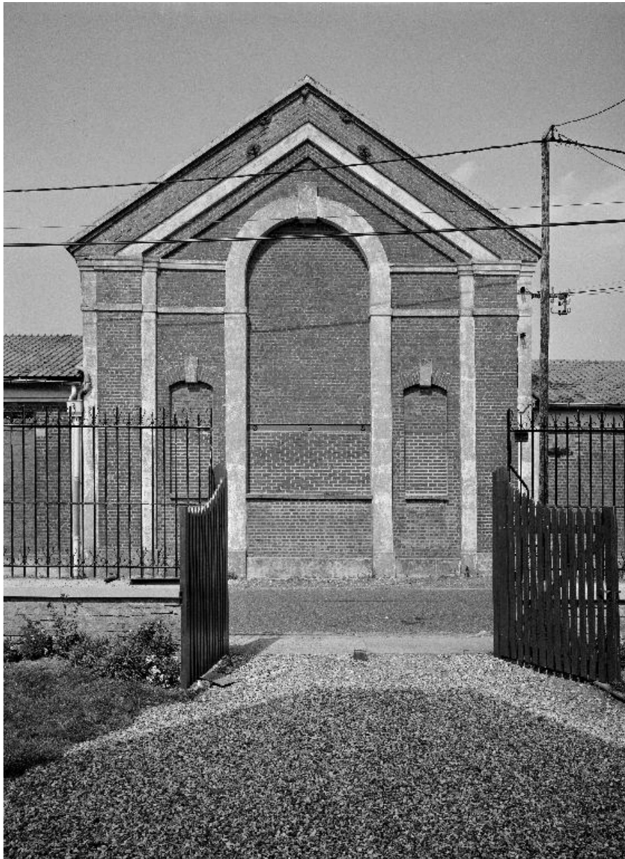
Corps de bâtiment C, flanc sud.
