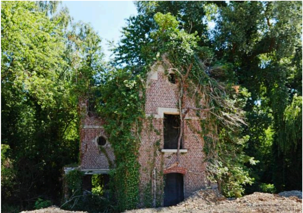
Ancienne maison de gardien de l'usine Kuhlmann.
