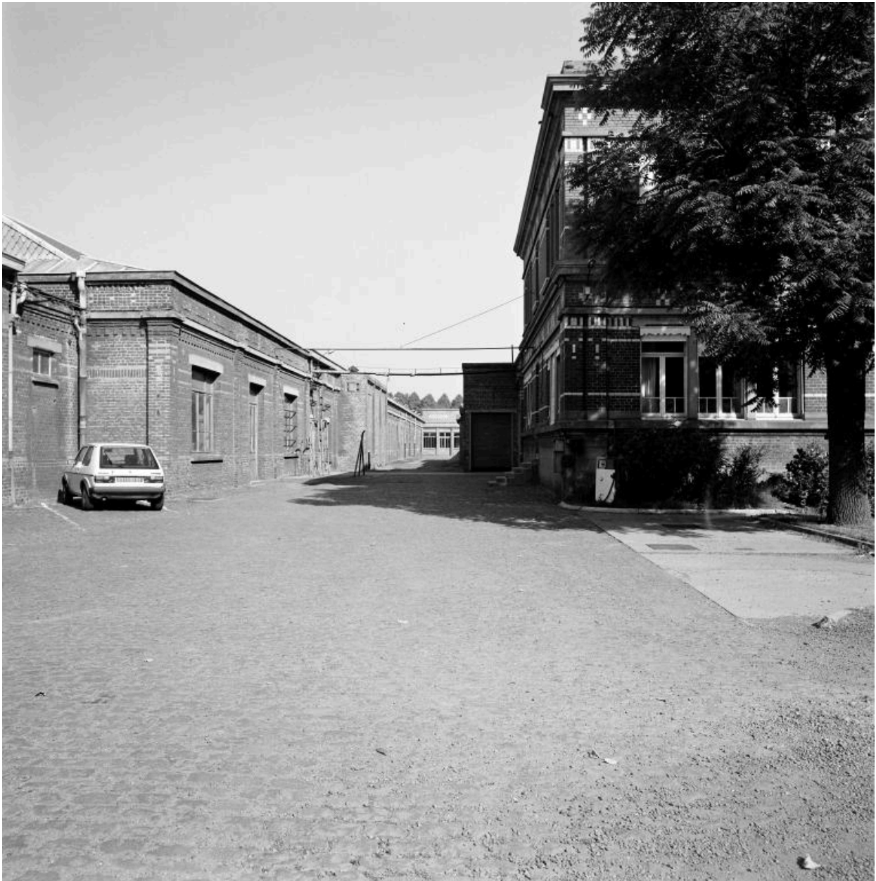
Bureaux et magasin aux toiles (à gauche). Vue prise vers le nord-ouest.
