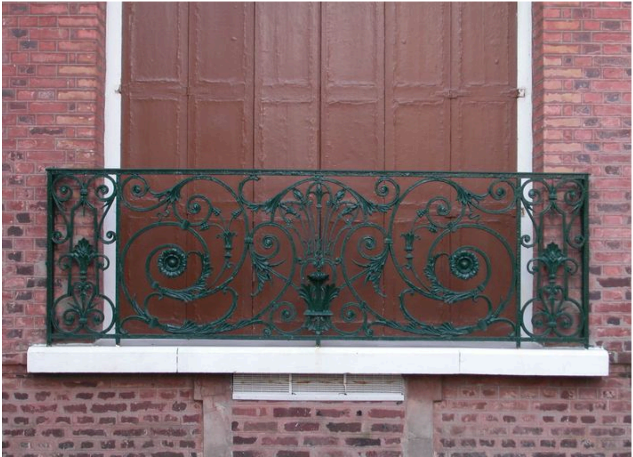
Détail du décor de fonderie du garde-corps du rez-de-chaussée.
