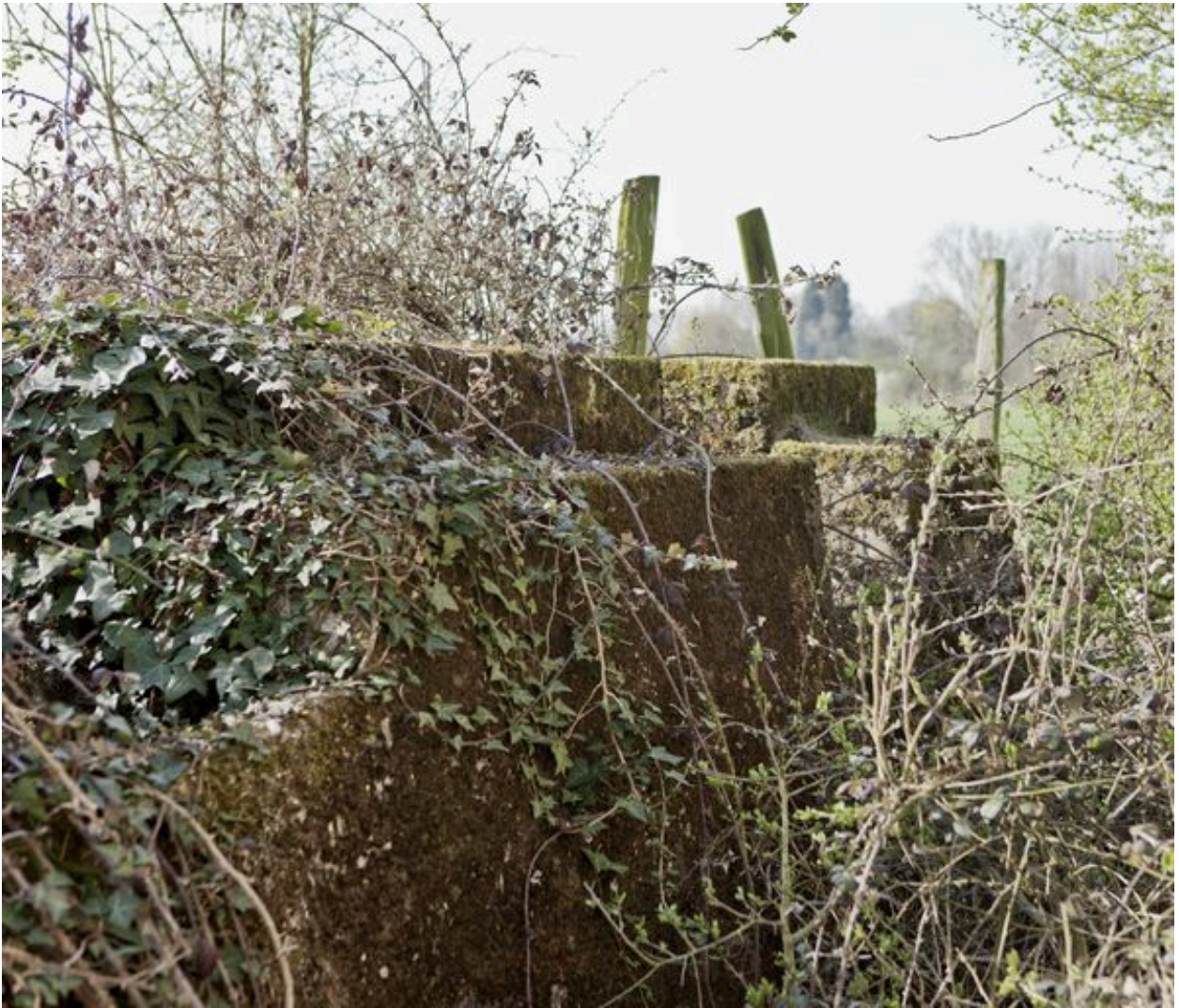
Au sud de l'édifice, massif de fixation des conduits d'évacuation d'eau
