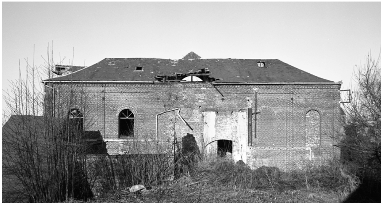
Elévation arrière de l'atelier de fabrication.
