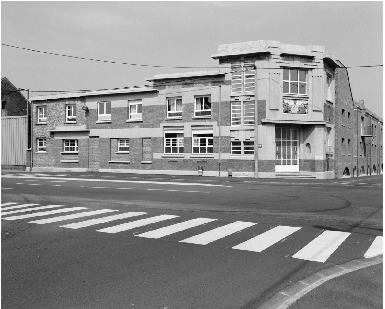
École Saint-Pierre, construite par l'architecte Adolphe Danis (1886-1969) vers 1930.
