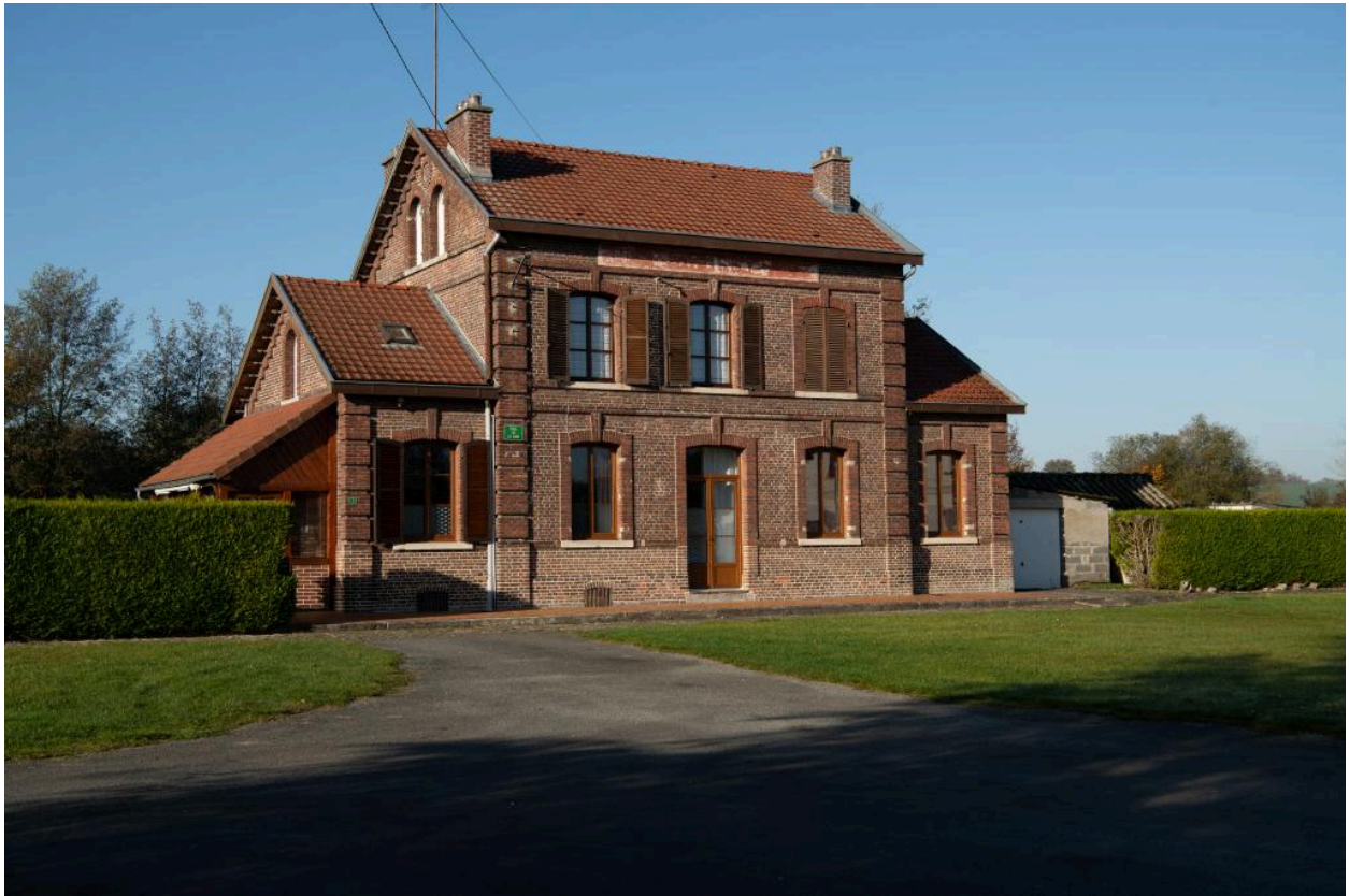
Façade de l'ancienne gare, n°1 place de la Gare, vue depuis le sud-est.
