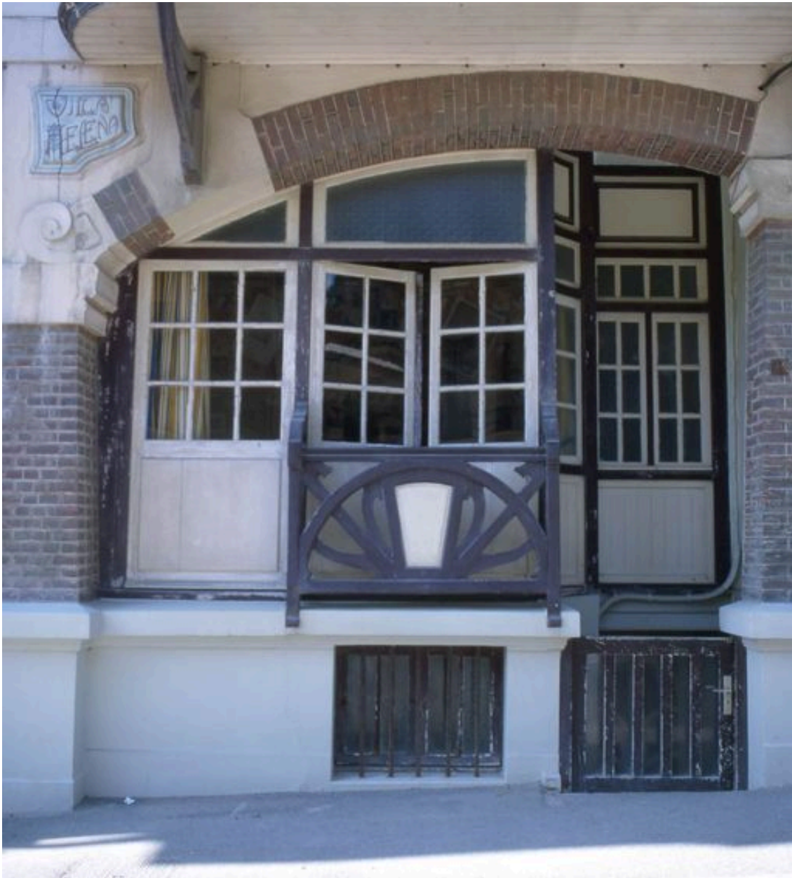
Détail du rez-de-chaussée surélevé de la Villa Hélène.
