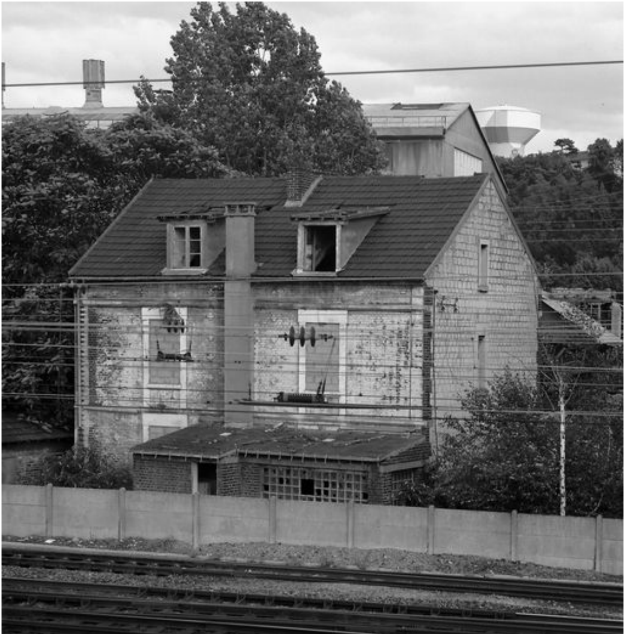
Logements d'ouvriers construits le long des voies ferrées.
