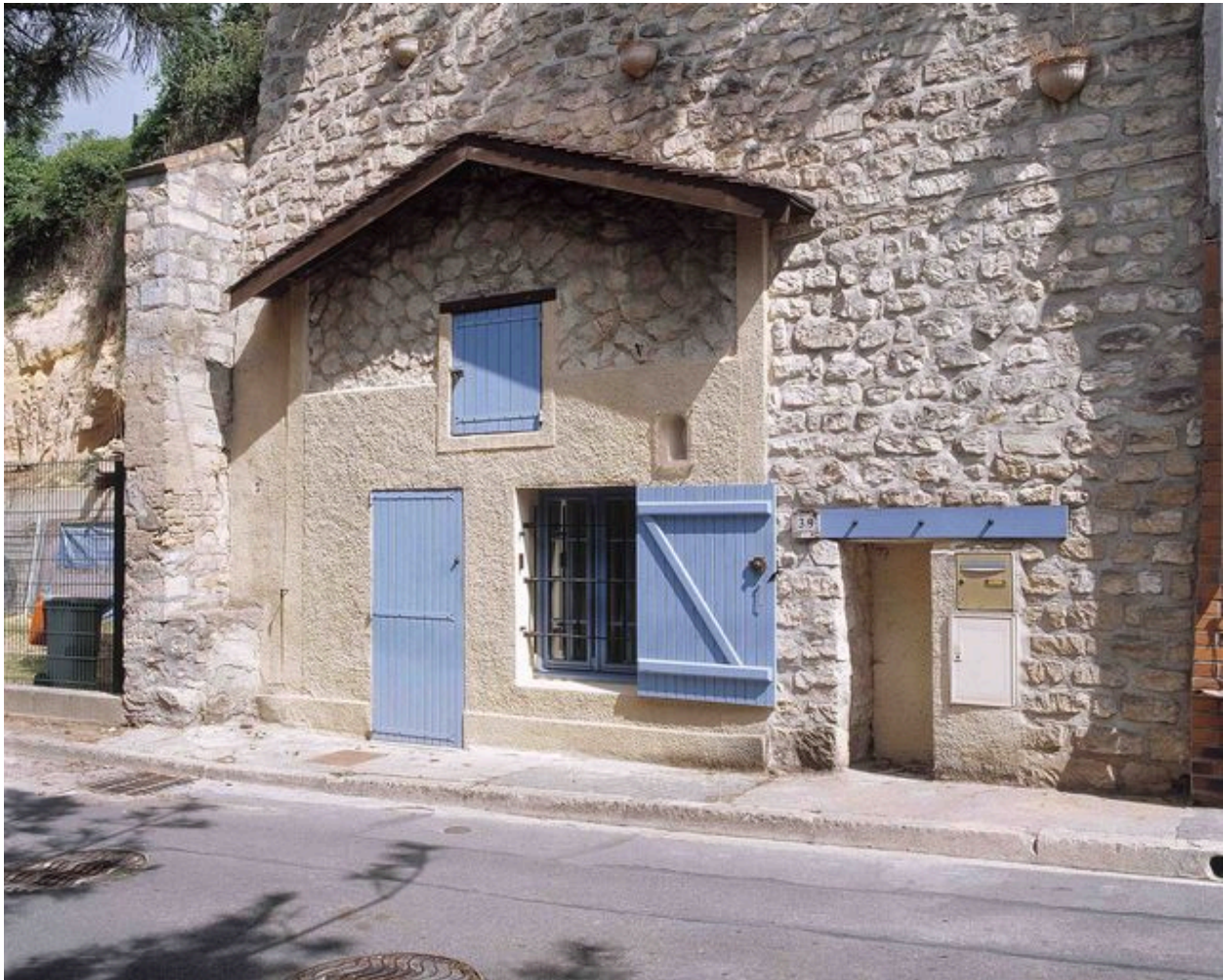
Habitation troglodytique rue des Hauts-Tufs à Creil.
