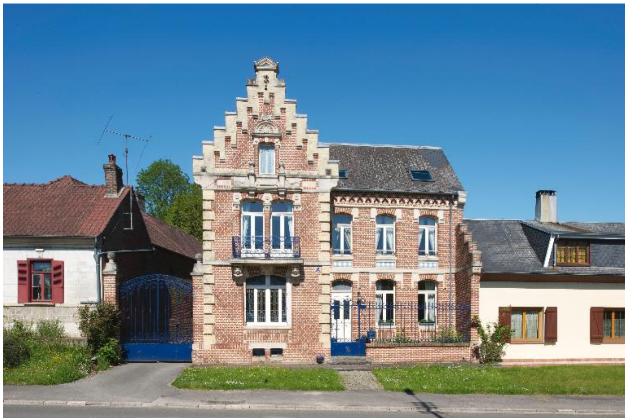
Façade sur rue, vue de face.
