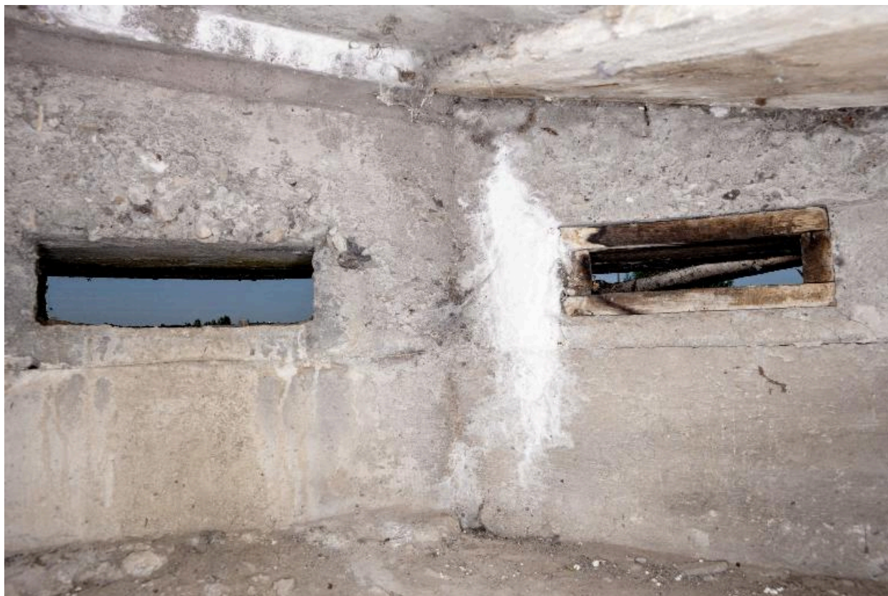
Observatoire bétonné, détail des embrasures de surveillance
