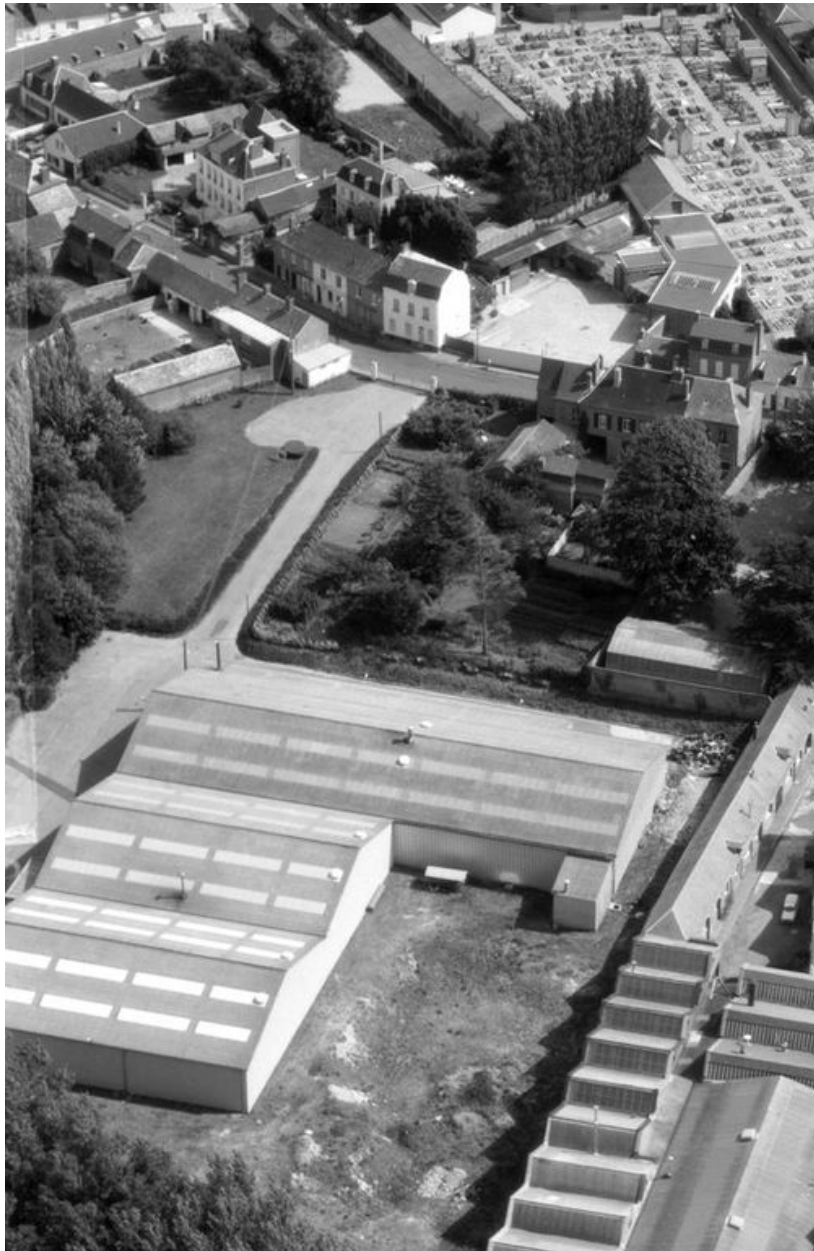
Vue aérienne, flanc nord-est, en 1988.
