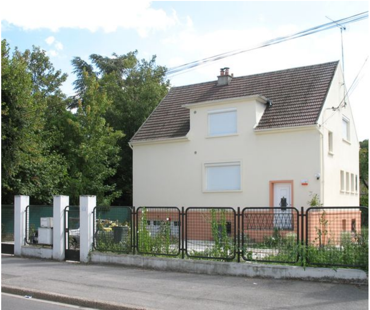
Maison d'ingénieur construite en 1958 rue Charles Somasco.
